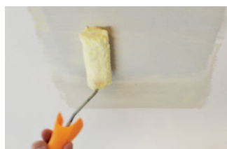
Penetrace stropů před malováním
