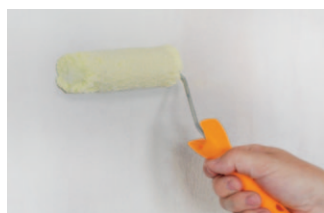
Penetrace stěn před malováním
