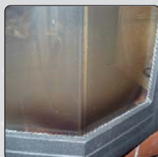
Foto 1: silně znečištěné sklo – původní stav
