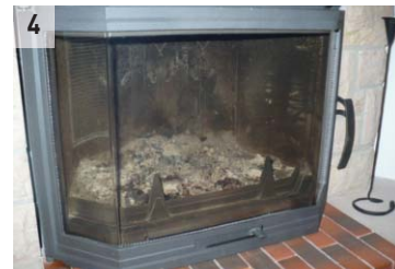
Foto 4: čisté průzračné sklo - výsledek po čištění
