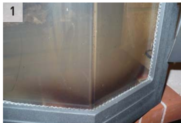
Foto 1: silně znečištěné sklo – původní stav
